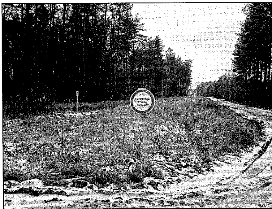
Рисунок 13 – Лесная растительность на отметке 0,8 км трассы газопровода
