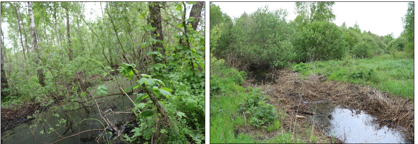
Рисунок 3.4 – Существующее состояние магистрального канала М1
