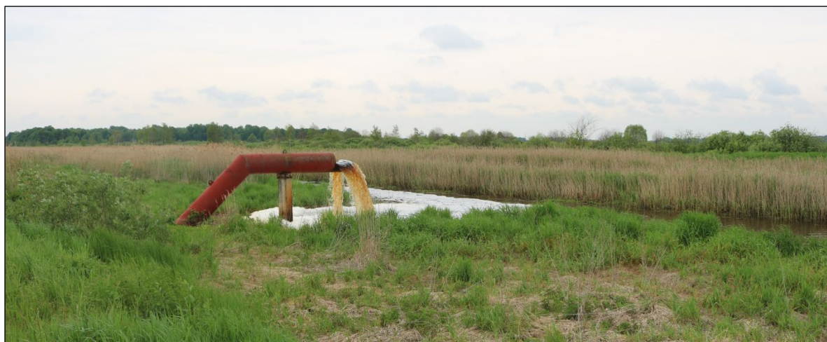
Рисунок 3.6 – Канал Домановичский в районе расположения насосной станции (май 2023 г.)
